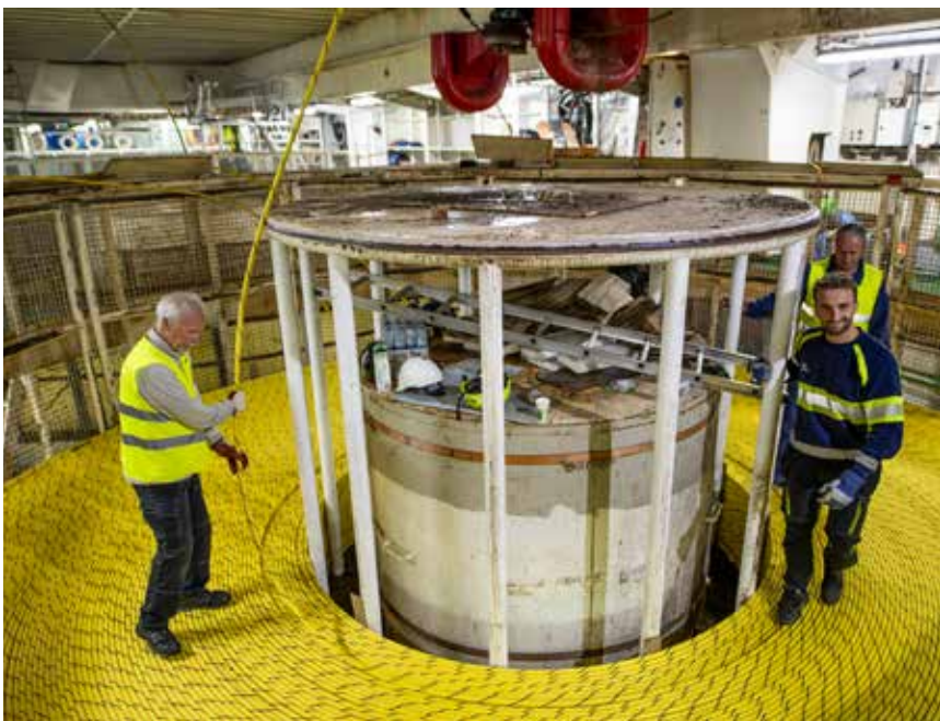
Ulf Strömberg, Hannes Örberg och Mats Åkesson arbetar med att lägga kabeln rätt när den spolas in i fartygets lastutrymme.
